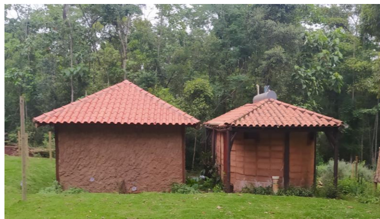
Figura 5.4 - Cozinha coletiva e casa de um dos proprietários
