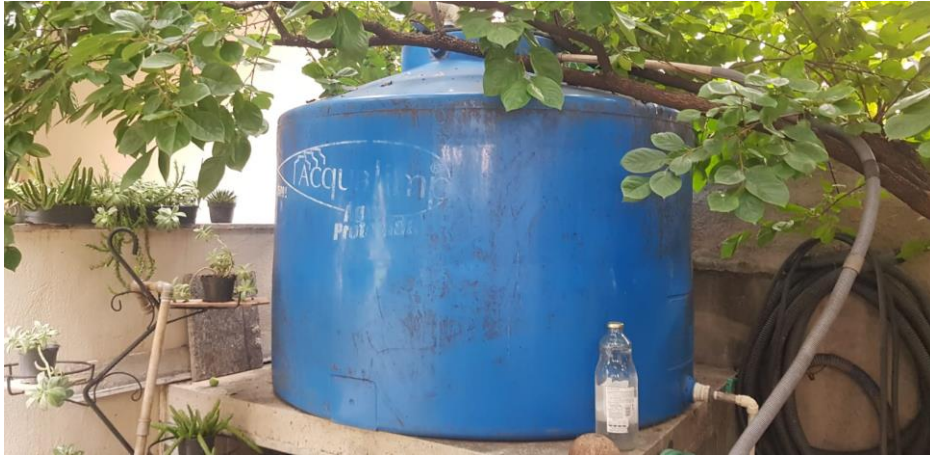
Figura 4.6 - Reservatório do SAAC que será analisado.
