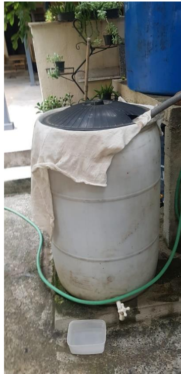
Figura 4.7 - Bombonas para armazenamento da água excedente do reservatório.
