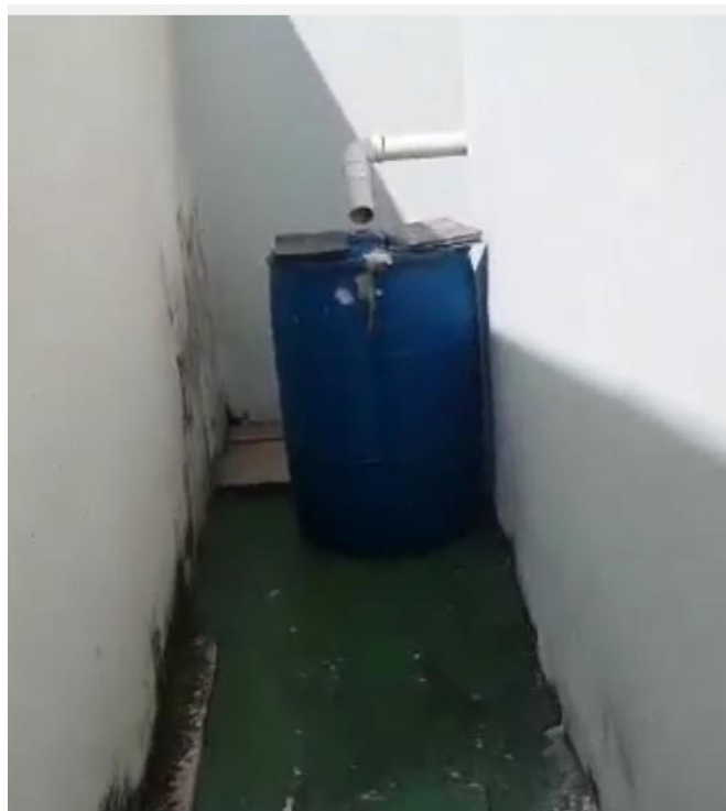
Figura 4.3 - Reservatório do SAAC que será analisado .
