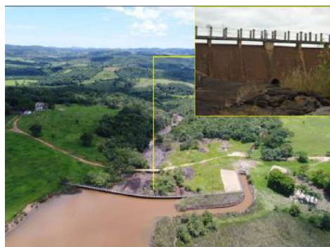
Figura 3.2 – Barragem da Central Geradora Hidrelétrica Monteiros
