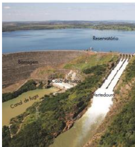
Figura 3.5 – Partes externas de usinas hidrelétricas
