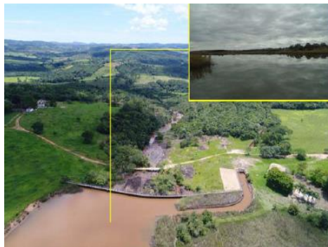
Figura 3.1 – Reservatório da Central Geradora Hidrelétrica Monteiros
