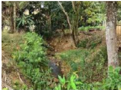
Figura 3.4 – Ponto à jusante do canal de restituição da Central Geradora Hidrelétrica Santa Cecília
