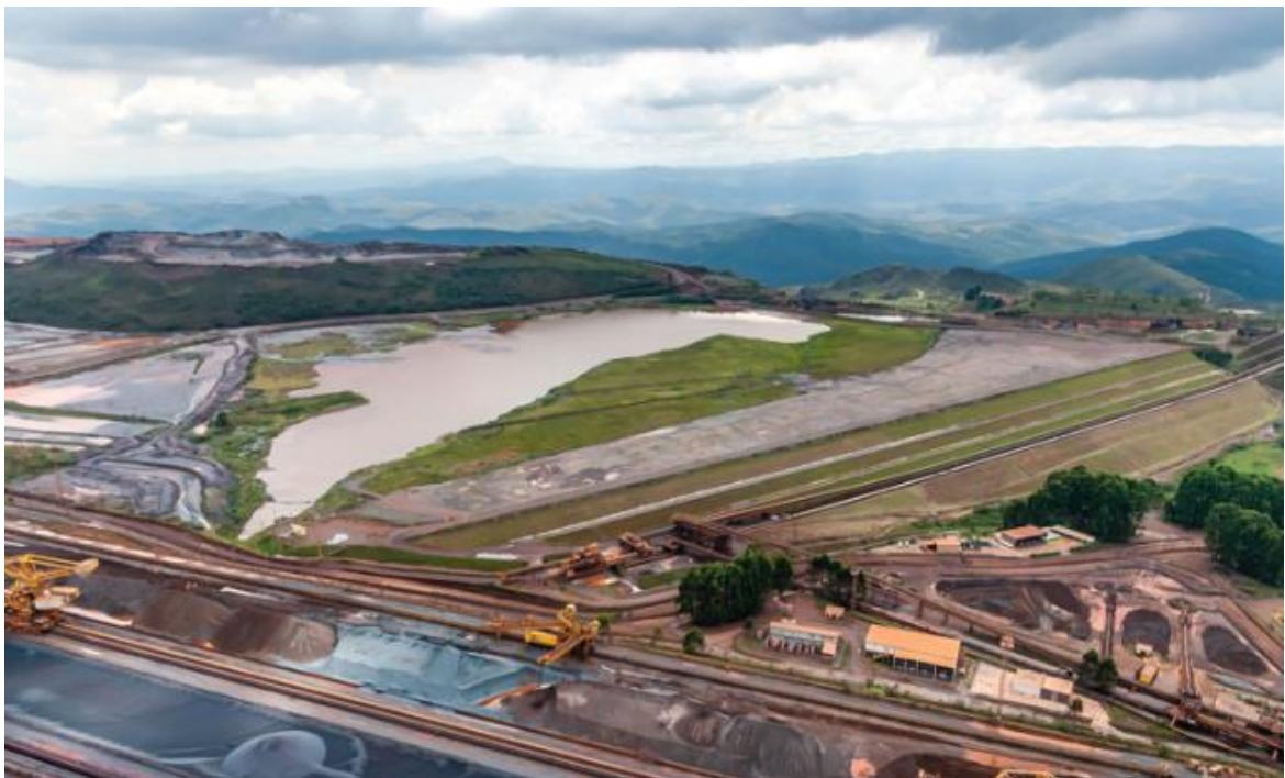
Figura 4.2 - Barragem de Rejeitos Localizada no Município de Nova Lima - MG.
