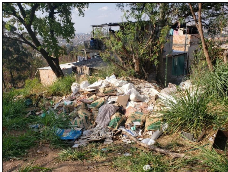
Figura 5.16 – Registro da visita de campo- Disposição de rejeitos e resíduos de construção civil (bota-fora) em área do CEA Barreiro.
