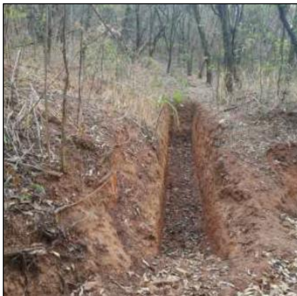
Figura 5.11 – Registro da visita de campo- Trincheira de infiltração de águas pluviais.
