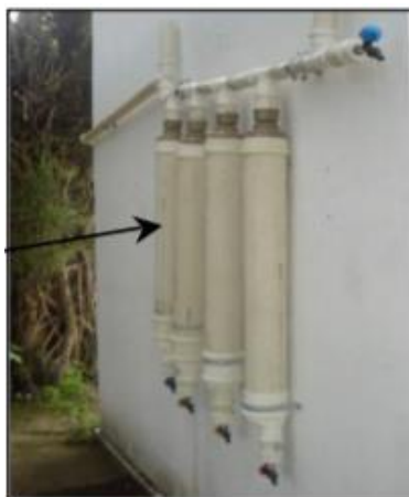
Figura 3.10 – Representação de um tipo de captação do volume de first-flush .
