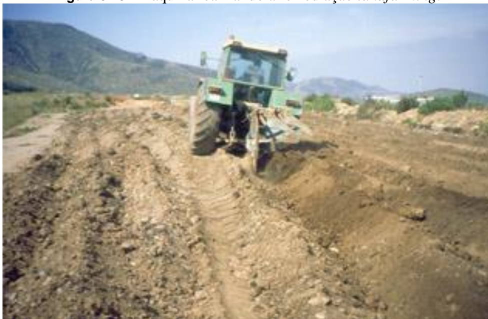
Figura 3.13 - Máquina realizando a remediação landfarming .
