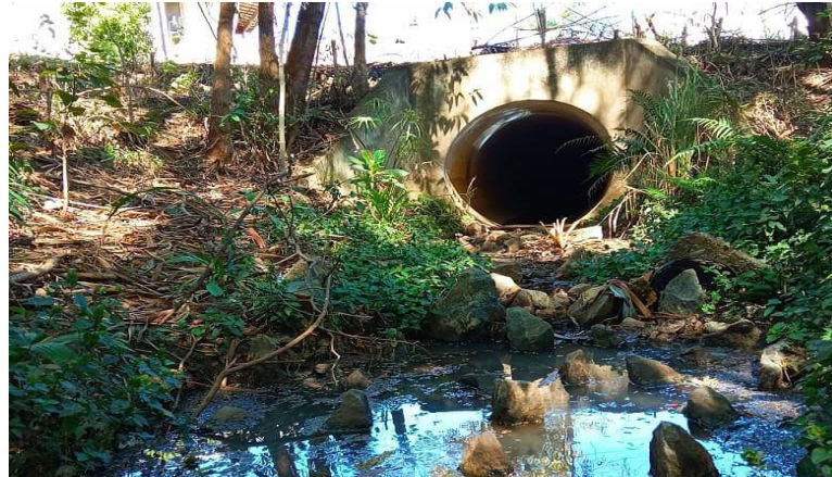
Figura 5.22 - Saída da galeria que drena nascentes externas ao parque
