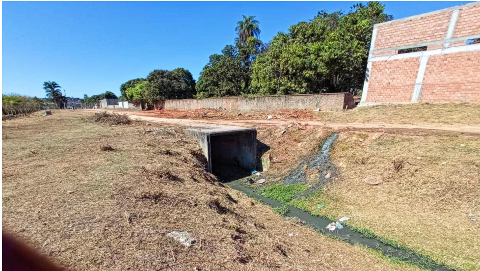
Figura 5.27- Início da canalização do córrego olhos d'água na Av. Francisco Negrão de Lima
