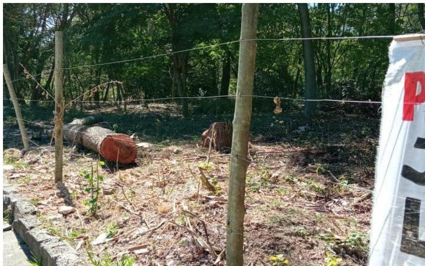
Figura 5.21- Supressão vegetal dentro do parque e em área de APP
