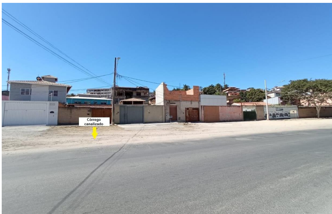
Figura 5.29: Avenida Francisco Negrão de Lima em trecho com córrego canalizado
