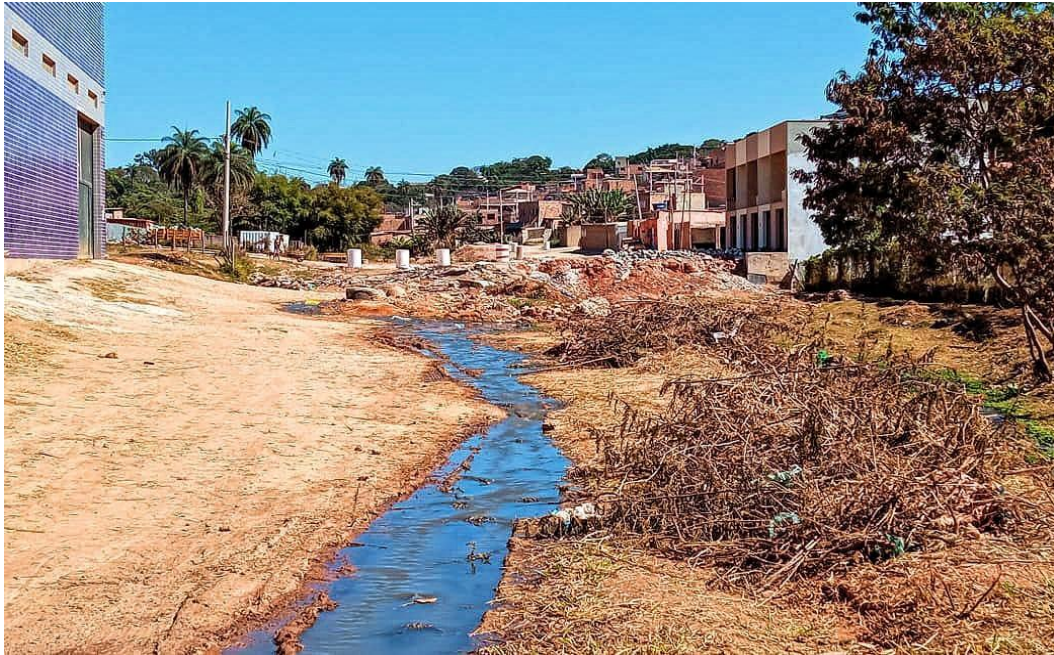
Figura 5.25- Esgoto corre pela avenida Francisco Negrão de Lima e cai no córrego
