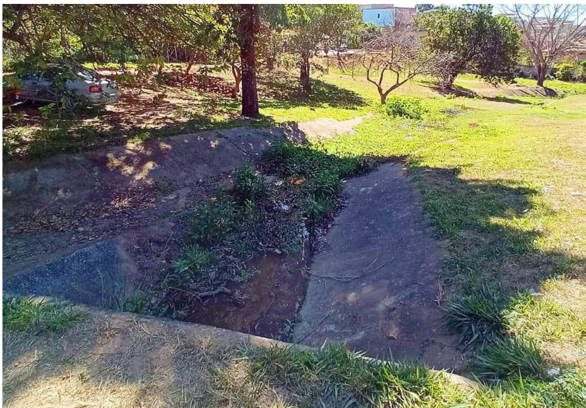
Figura 5.24- Saída da drenagem das nascentes por galeria pluvial
