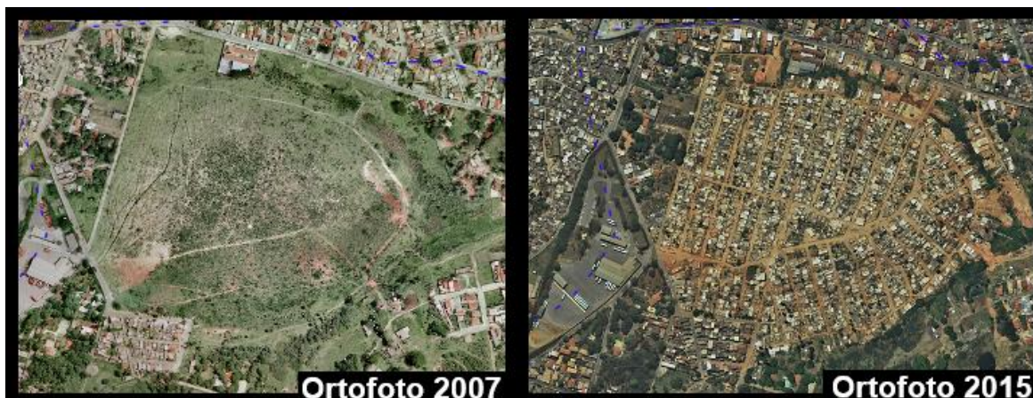
Figura 5.3- Imagens áreas comparativas do antes e depois da Ocupação Dandara.
